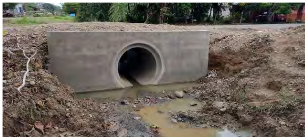
Construcción de cabezales Código de camino 6-05-021 Calles Urbanas Cuadrantes Puerto Cortés (Barrio Precario)
