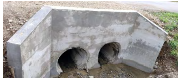
Construcción de cabezales Código de camino 6-05-021 Calles Urbanas Cuadrantes Puerto Cortés (Barrio Precario)
