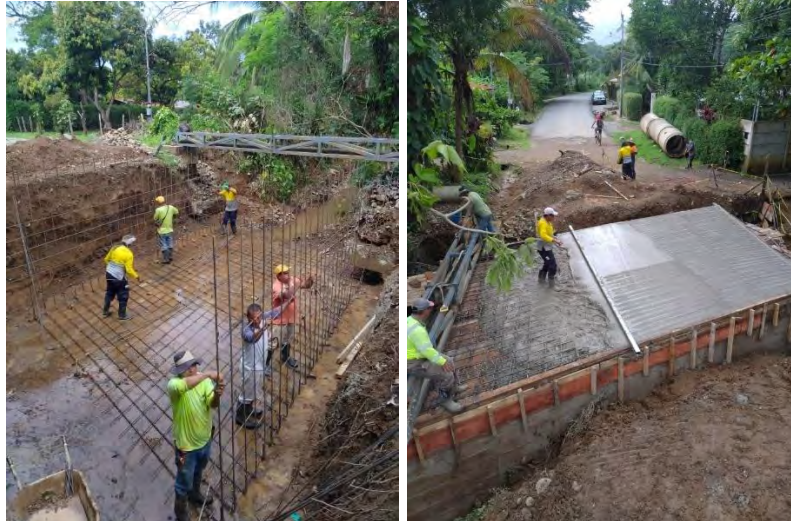
Construcción de cabezales Código de camino 6-05-021 Calles Urbanas Cuadrantes Puerto Cortés (Barrio Precario)
