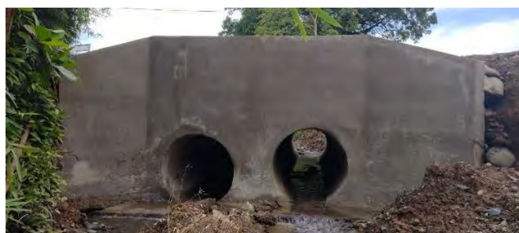
Construcción de cabezales. Código de camino 6-05-001 (Entr.N.168) Parque de Ciudad Cortés a (Entr.C.97) Finca Las Delicias
