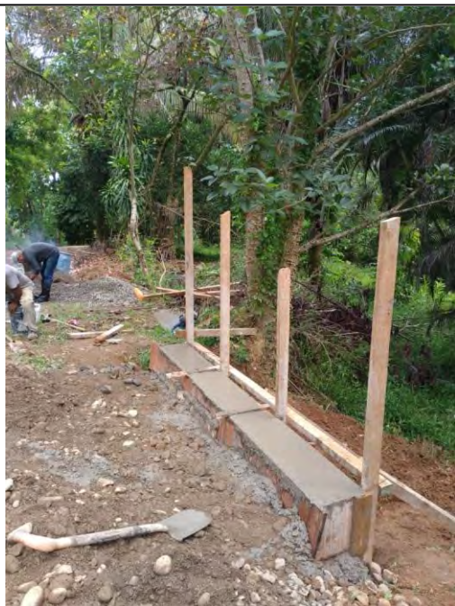
Proyecto construcción de cabezales en Playa Hermosa mediante convenio con la ADI de Uvita, Comité de Caminos, Municipalidad de Osa y Ministerio de Trabajo (PRONAE MTSS)
